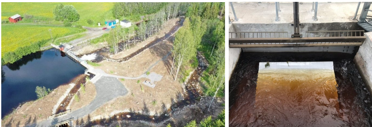
Till vänster omlöp Rällsälvs vattenkraftverk och till höger avledare för nedströmsvandrande fisk vid inloppet till kraftverket.
