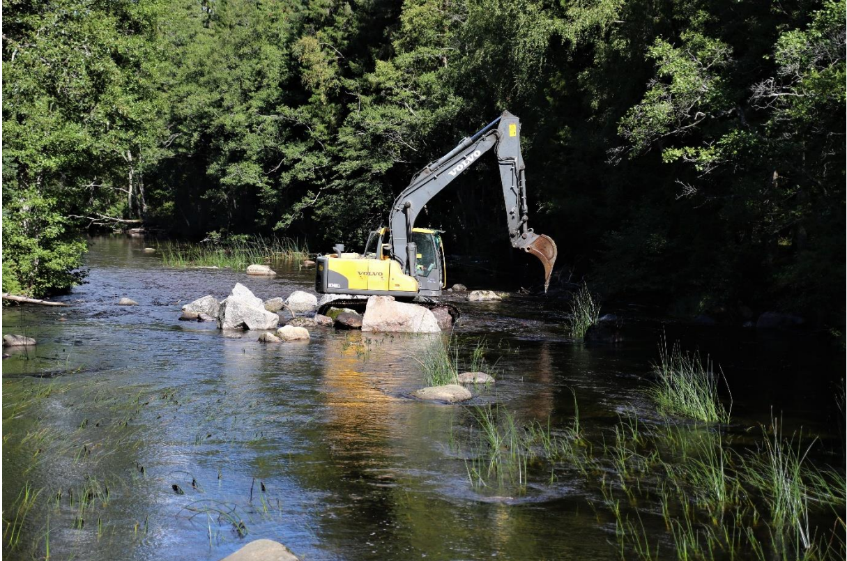
Figur 6. Den större av de två återskapade öarna byggdes upp med större stenar och block.
