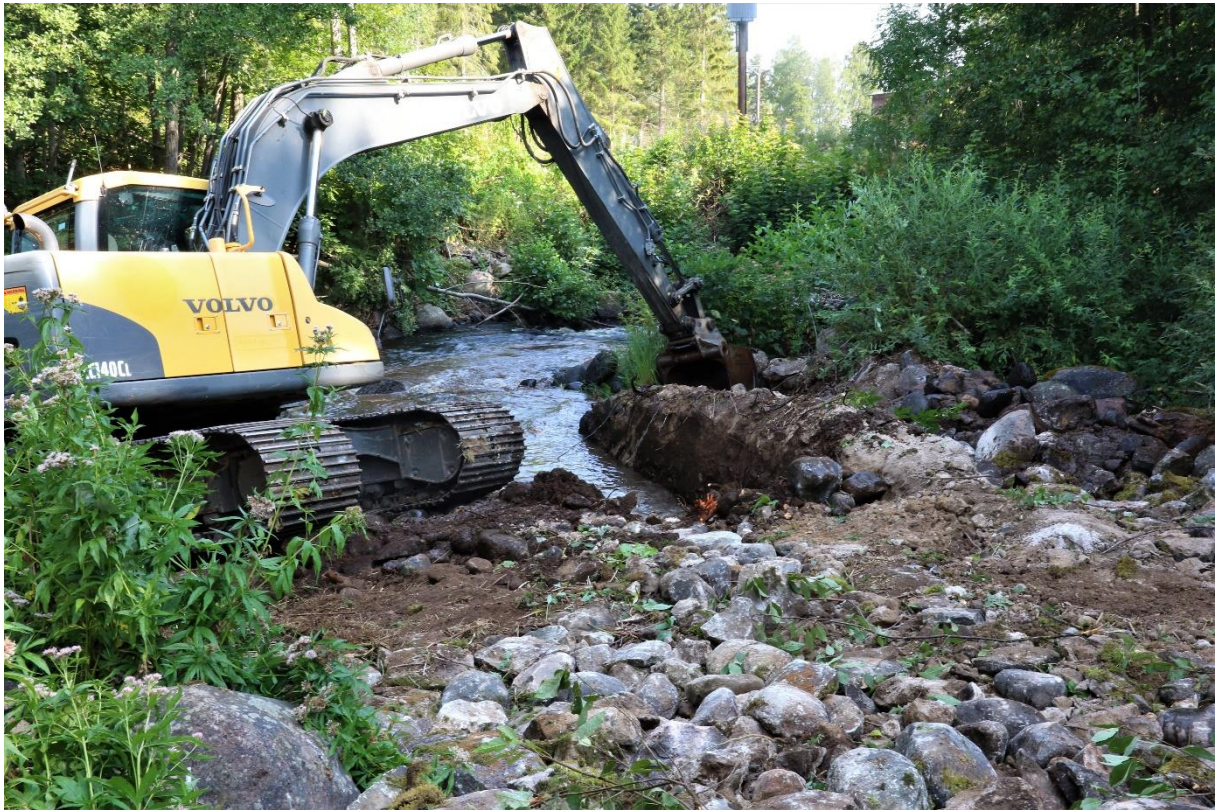
Figur 2. På bilden syns det gamla betongdämmet som låg begravt under rasmassorna.
