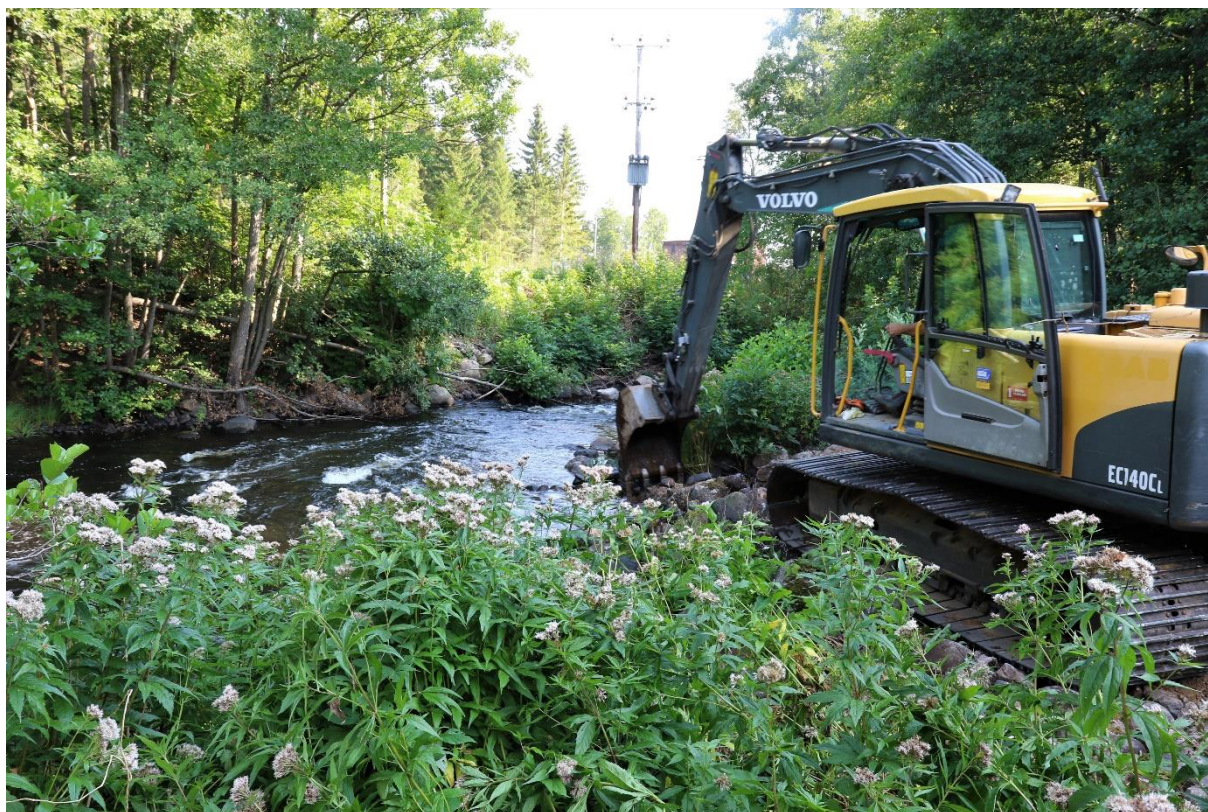
Figur 1. Ett av de första grävtagen vid den raserade dammen.
