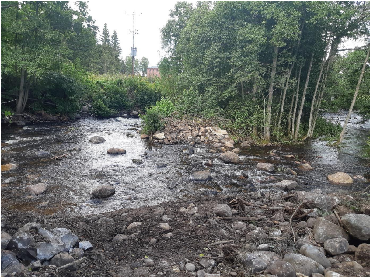
Figur 3. Efter åtgärd. Betongdämmet borta och sten och grus tillfört.
