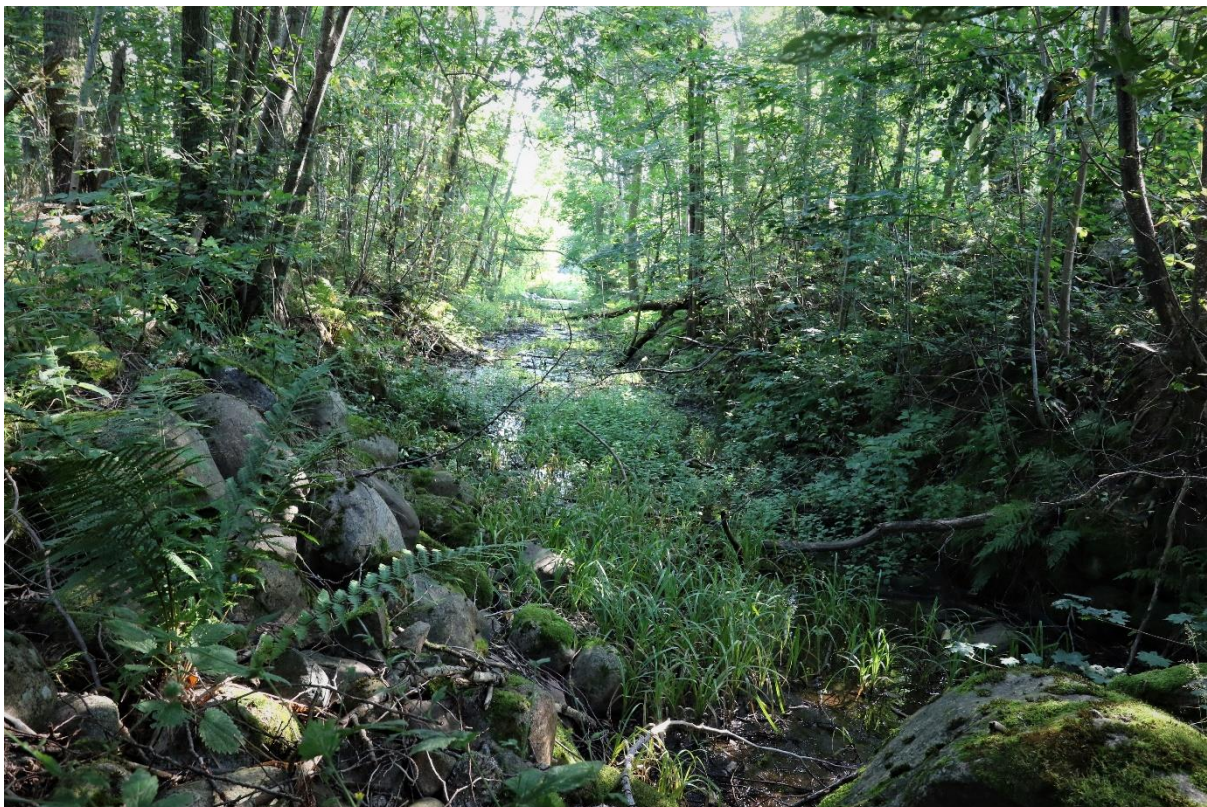
Figur 4. Utloppskanal innan åtgärd. Stensamlingen till vänster i bild justerades vid åtgärdsarbetet.
