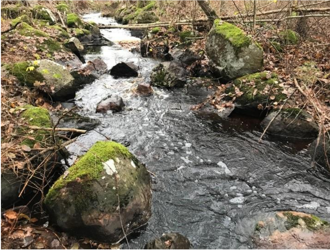
Efter åtgärd. Stenar har flyttats för att underlätta fiskpassage
